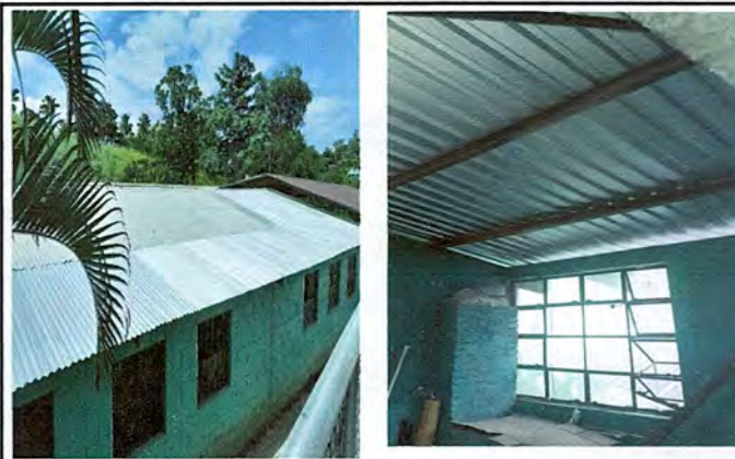
Foto 2: Vista del Techado de una parte de las aulas y techado de la cocina. proyectos concluidos en su totalidad.
