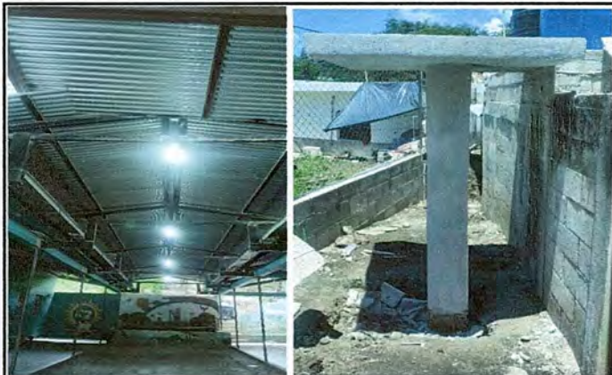
Foto 1: Vista del proyecto finalizado del mejoramiento de cableado de energía eléctrica y base terminada del tinaco.
